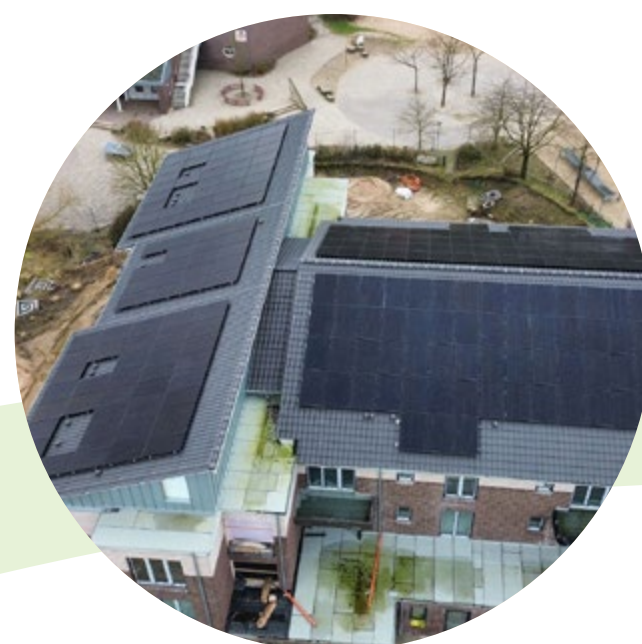
Kita Mittendrin und Wohnen mit PV-Anlage
